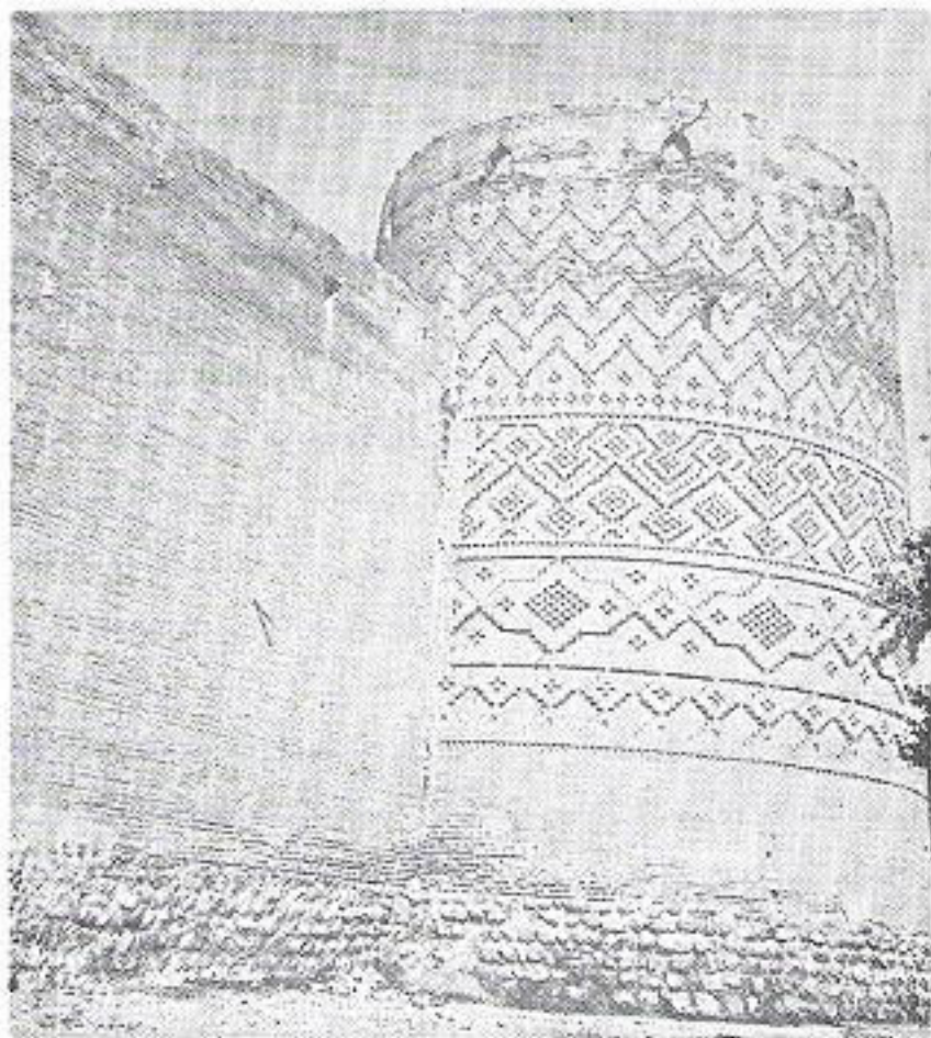
قسمتی از دیوار و یکی از برجهای ارگ
